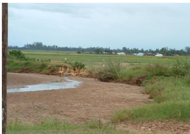
Infrastructure hydroagricole à Alaotra ravagée par la crue
