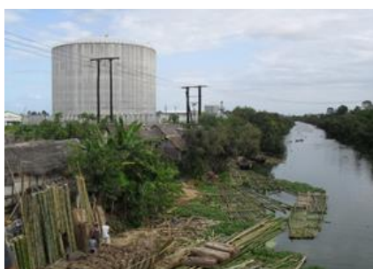
Réservoir d'ammoniac pur sur les berges du Pangalana (Maharavo, 2016)
